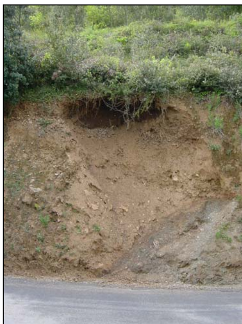
↑ Reynès – Ravinement le long de la D15 Photographies RTM
