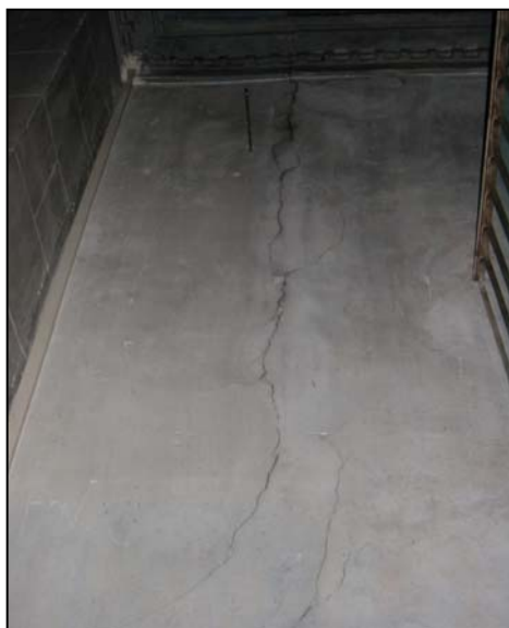
Village de Reynès – Fissures affectant l'église (intérieur et extérieur) Photographie RTM 2001
