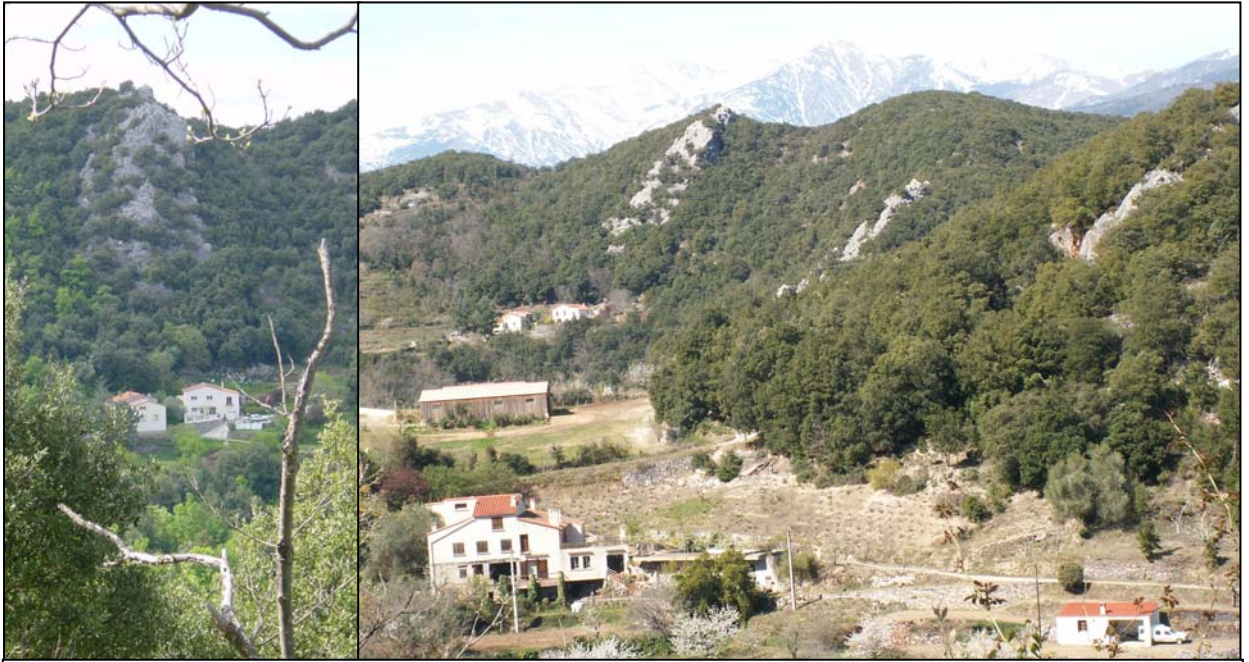
↑ Reynès – Chutes de blocs . Dans le secteur Canadeils-Puig dels Argelers : habitations directement sous les éperons rocheux. Photographies RTM
