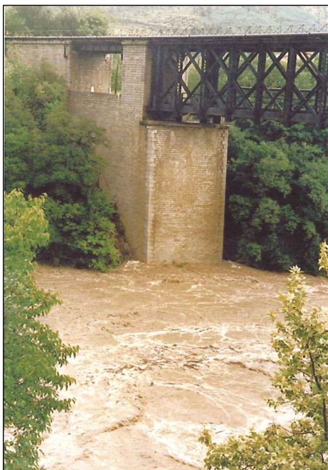
↩ Reynès – Le Tech en crue le 10 octobre 1987
