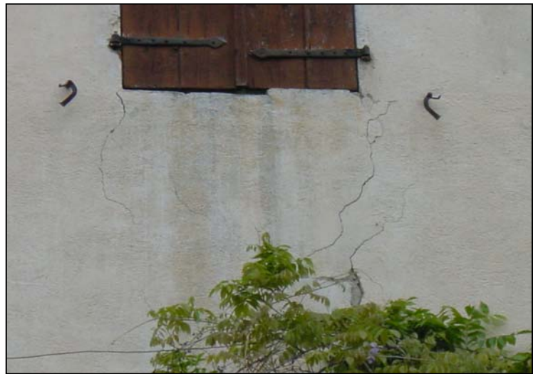
↑ ↩ Village de Reynès – Fissures affectant les habitations du village Photographie RTM 2001
