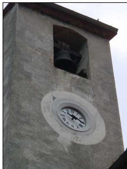
Village de Reynès – Fissures affectant l'église (intérieur et extérieur) Photographie RTM 2001
