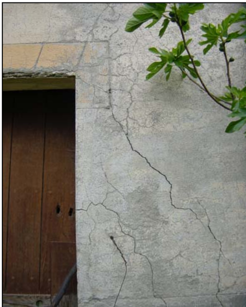
↑ ↩ Village de Reynès – Fissures affectant les habitations du village Photographie RTM 2001
