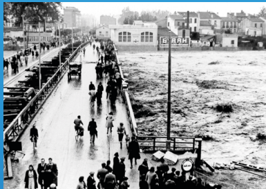
Du 16 au 20 octobre 1940 - Destruction Tout le département a été ravagé sauf la Cerdagne, le Capcir, la Côte Vermeille. 48 victimes dans la vallée du Tech, destruction de plus de 200 immeubles.
