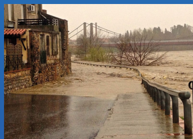
4/8 mars 2013 - Gros dégâts Le département s'est réveillé après une nuit cauchemardesque. La rupture d'une digue de l'Agly a causé des dégâts considérables.
