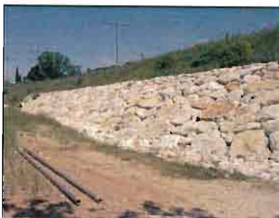
Exemple d'enrochement
