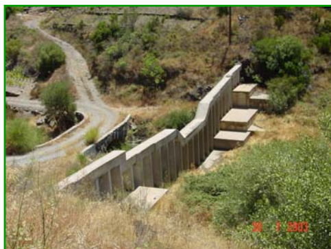
Barrage à l'amont du mas Parer sur le ravin de la Baillaury.
