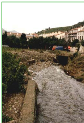
Amont de la Maison de retraite : débordement du Sérís en rive droite au niveau de l'entrée du passage souterrain sous-dimensionné lors de la crue de 1987.
