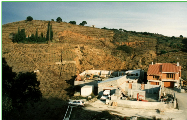
Glissement de terrain de la ZAC de la Réthorie. Le mur d'enceinte de l'entrepôt présente des signes de faiblesse, la maison est menacée.
