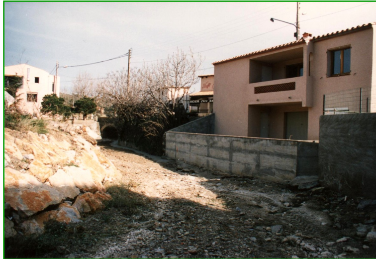
Bâtiment construit dans le lit du Coma-Pascole
