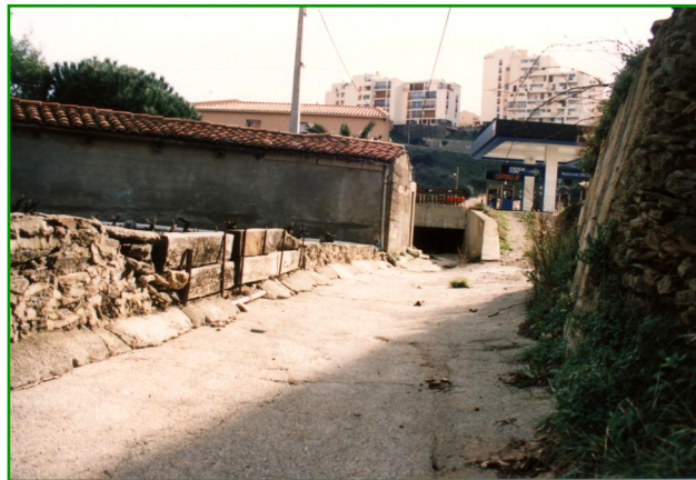
Chenal du ravin des Redoulères en amont de la RN 114
