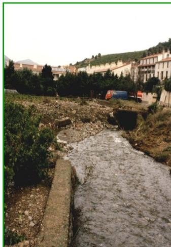
*Amont du bâtiment Paul Reig : débordement du Sérís en rive droite au niveau de l'entrée du passage souterrain sous-dimensionné lors de la crue de 1987.*
