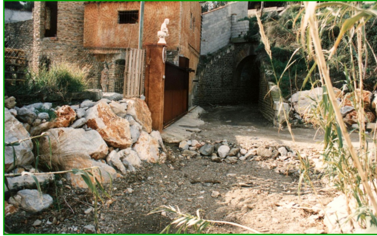
Accès à la cave située à l'aval immédiat Accès à la cave située à l'aval immédiat de la voie SNCF, en rive droite du Coma-Pascole. Noter l'absence de berge à ce niveau.
