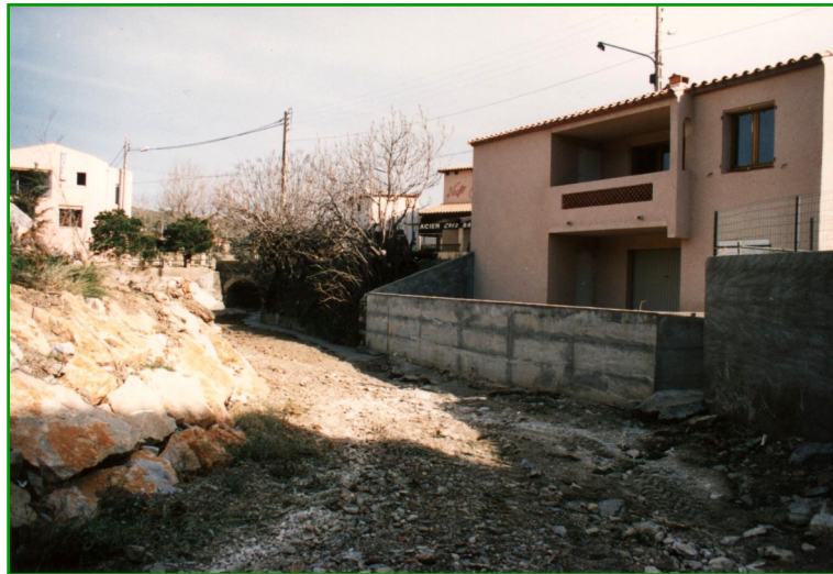
Bâtiment construit dans le lit du Coma-Pascole
