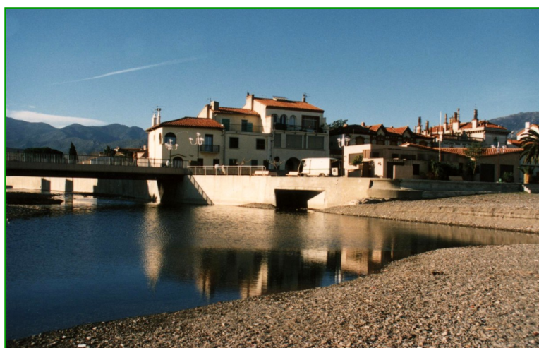
Le débouché de la Baillaury dans la mer. Le dalot au centre de la photo correspond à l'exutoire de l'ancien lit du Vall Pompo.
