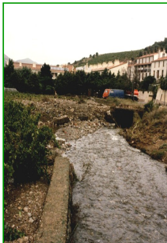
Amont du bâtiment Paul Reig : débordement du Sérís en rive droite au niveau de l'entrée du passage souterrain sous-dimensionné lors de la crue de 1987.
