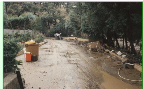
Aval du bâtiment Paul Reig après la crue du Sérís de 1987
