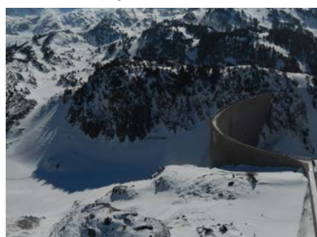
Barrage du Lanoux, DREAL Occitanie
