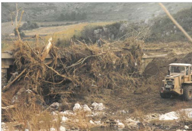
ESTAGEL. Embâcle au pont sur le Verdoube avant sa confluence avec l'Agly, à l'occasion de la crue de septembre 1999 (RTM, 1999)
