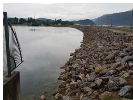
Barrage des Escourmes, Parement, DREAL Occitanie
