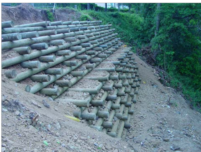
Arles-sur-Tech. Soutènement d'un talus en caisson bois (RTM, 2006)
