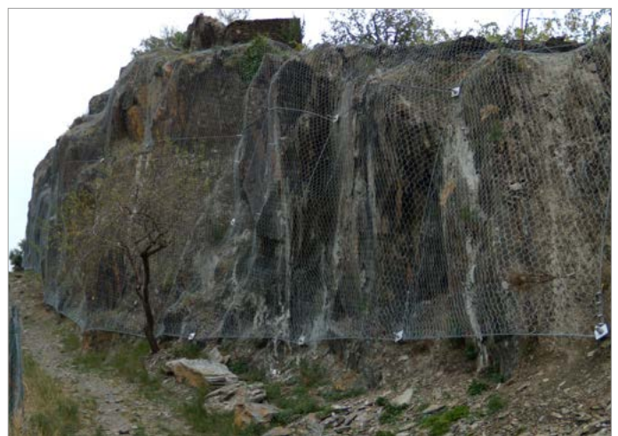
Port-Vendres. Protection de la ligne SNCF par mise en place d'un filet plaqué et ancré (RTM, 2008)
