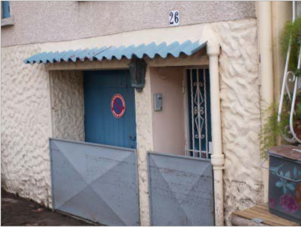
ARGELES-SUR-MER. Batardeaux mis en place ayant permis de ne pas être inondé à l'occasion de la crue de la Massane en novembre 2014 (RTM, 2014)
