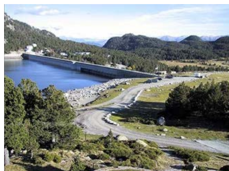
Barrage des Bouillouses
