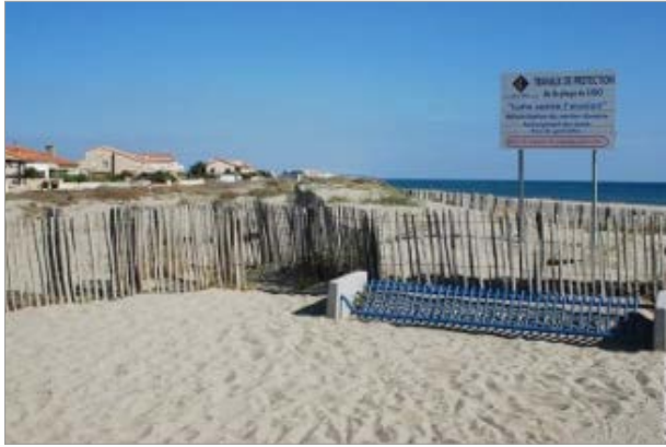
Réhabilitation douce du cordon dunaire au Barcarès par la pose de ganivelles © DREAL Occitanie
