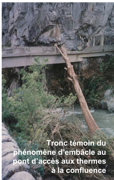
Embâcle au pont de la RD117 sur la Boulzanne
