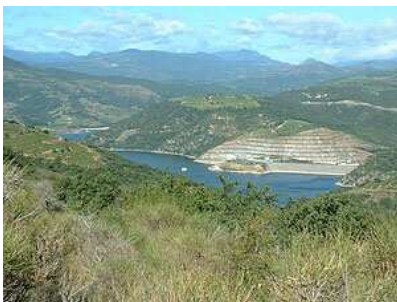
Barrage sur l'Agly
