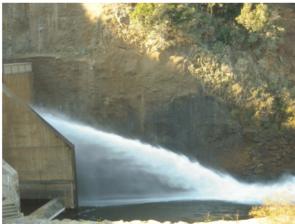
Barrage sur l'Agly
