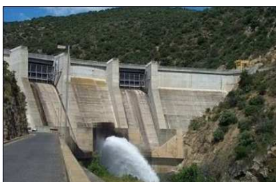
Barrage de Vinça
