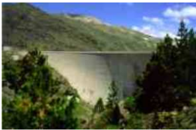
Barrage du Lanoux
