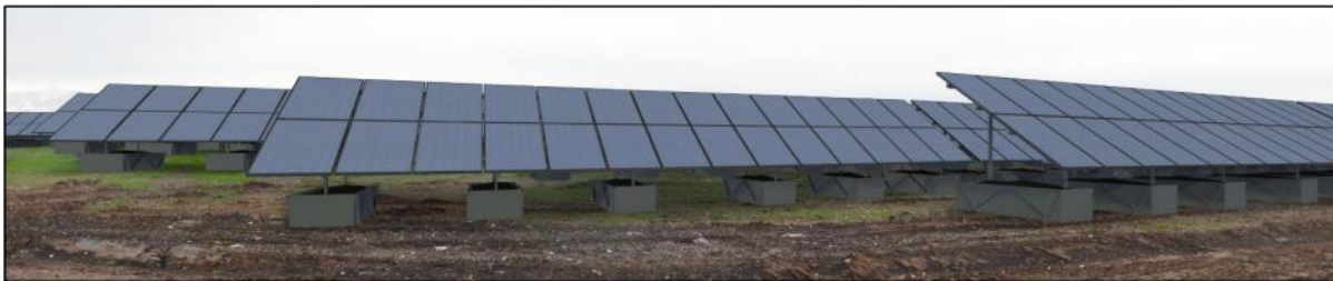
Figure 1 : Exemple de structure fixée sur bacs lestés
